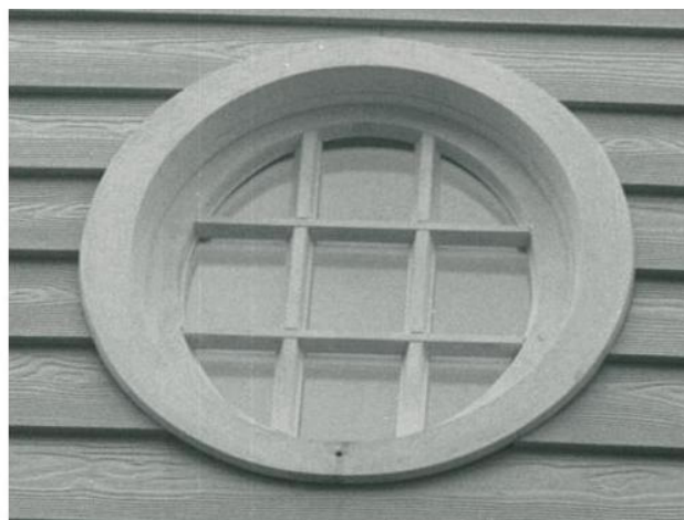
Отделка контура окна с помощью наличника
